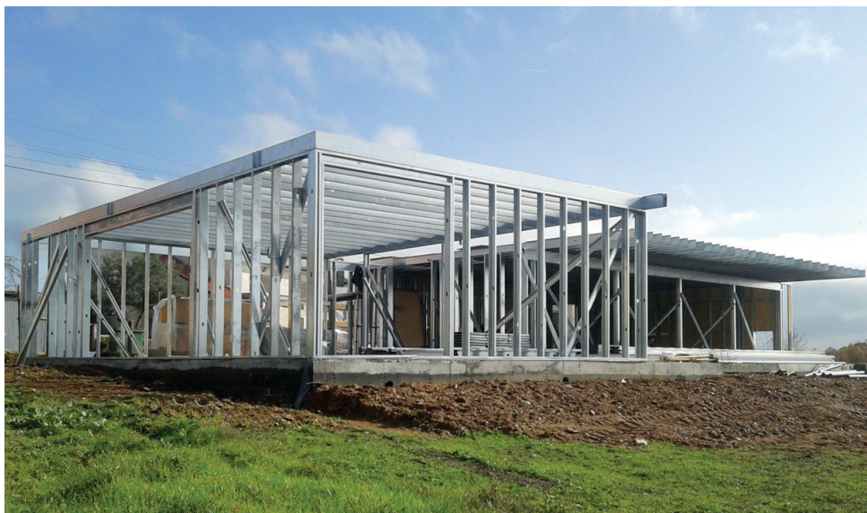
FIGURA 12.1. • Construção em LSF
