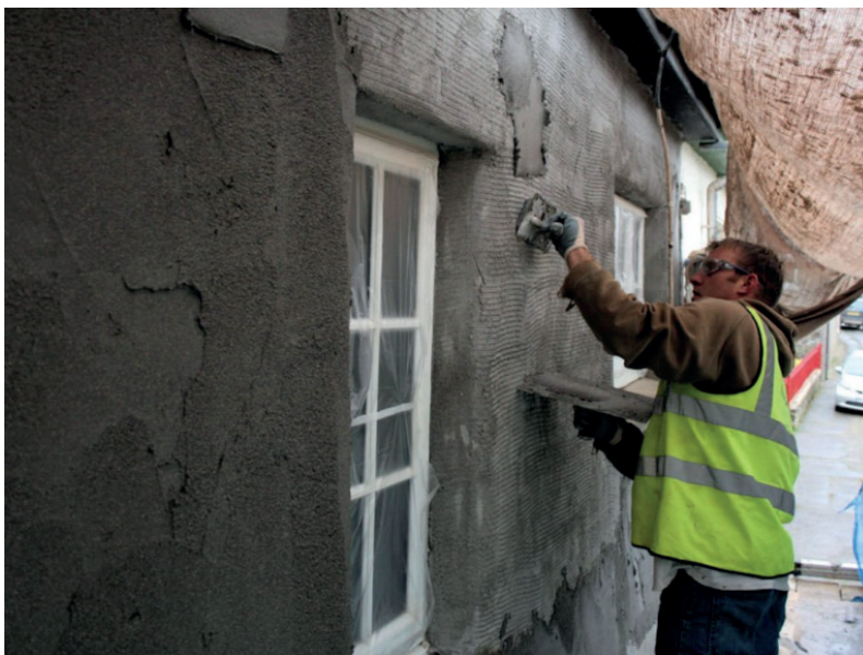
FIGURA 3.1. • Aplicação de reboco térmico
