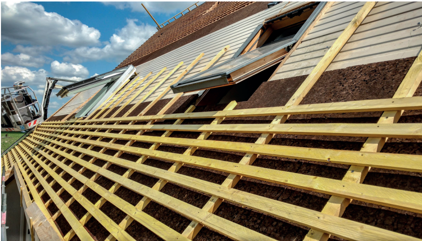
FIGURA 6.8. • Isolamento de coberturas inclinadas Fonte: isocor.pt/galeria/isolamento-de-coberturas-inclinadas
