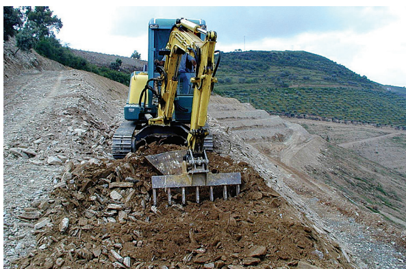
Figura 9.5 – Trabalhos de regularização do patamar e dos taludes. Fotos do autor.
