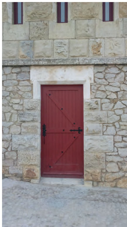
Figuras 2.8. e 2.9. – Portas simples de carpintaria elementar com padieira de pedra inteira. Fotos de: Victor Neves. Figures 2.8. and 2.9. – Simple elementary woodwork doors with stone entire lintel. Photos by: Victor Neves.
