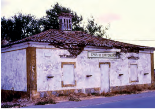
Figura 5.2. – Casa de cantoneiros abandonada e emparedada em Alentejo, Portugal.
