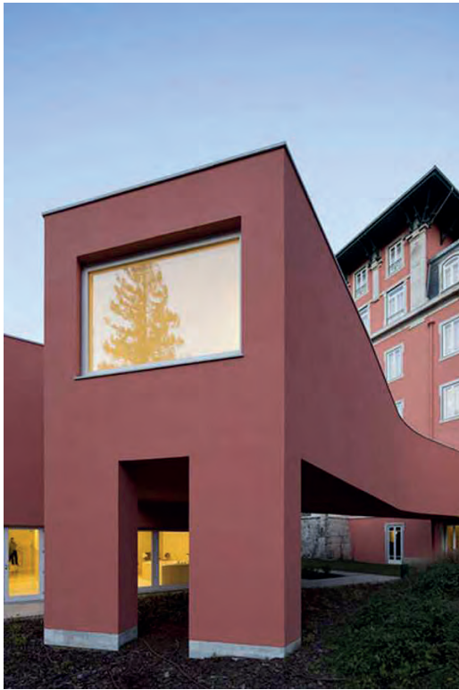
Figura 3.41. – Pavilhão do Spa de Vidago, Portugal (Álvaro Siza Vieira).
