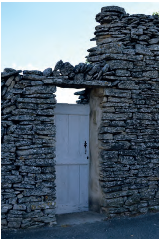
Figuras 2.8. e 2.9. – Portas simples de carpintaria elementar com padieira de pedra inteira. Fotos de: Victor Neves. Figures 2.8. and 2.9. – Simple elementary woodwork doors with stone entire lintel. Photos by: Victor Neves.
