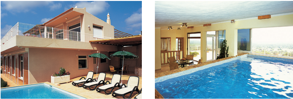
Figura 2.13. Casa com elevada inércia térmica
