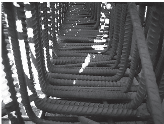
Figura 1.1. Excesso de armadura que dificulta a ligação betão-ferro.
