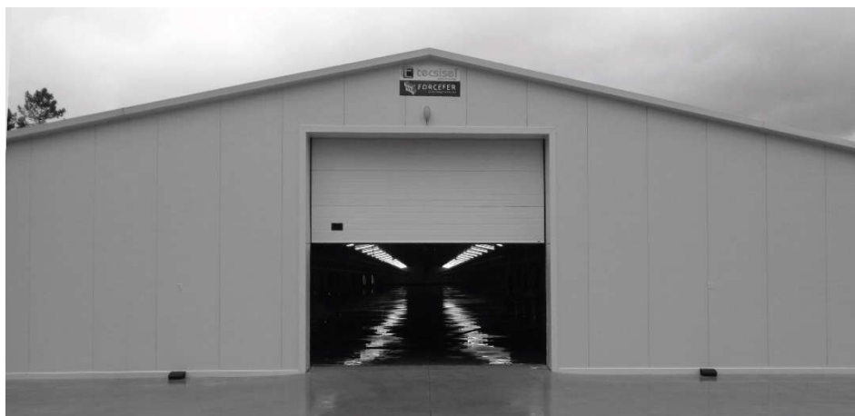
Figura 3.31. Exterior do pavilhão avícola, após a respetiva lavagem.
