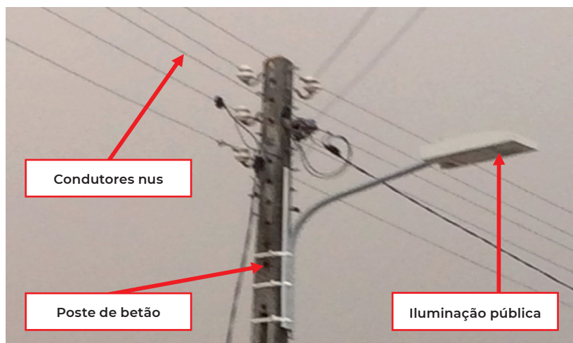
Figura 14.1. – RBT aérea com condutores nus
