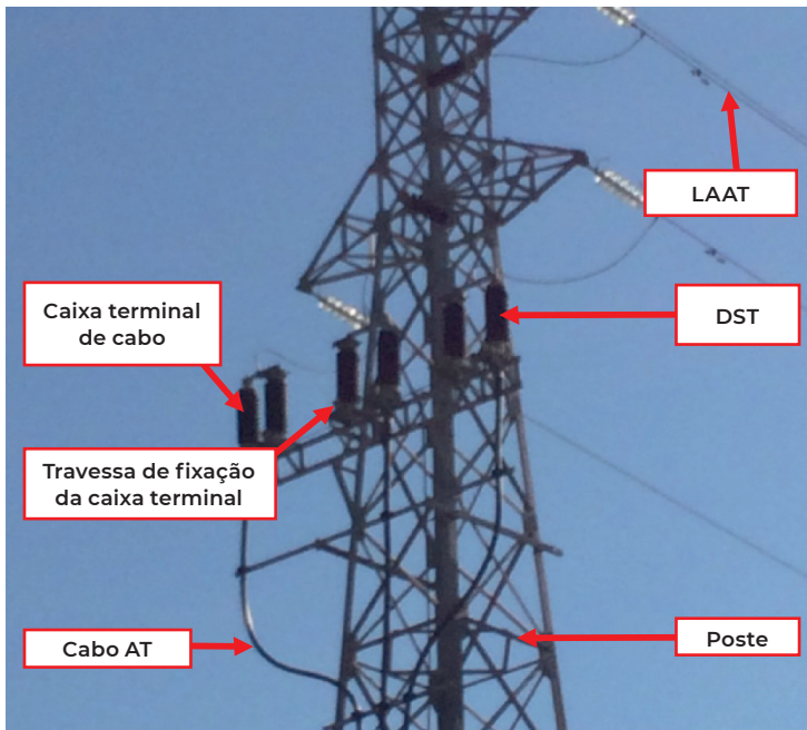
Figura 9.2. – Transição rede área/rede subterrânea – LAAT
