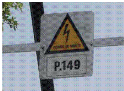
Figura 6.60. – Sinalização de perigo de morte e de identificação do apoio
