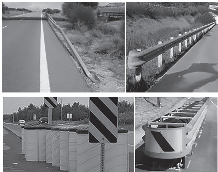
Figura 88. Várias soluções para o início dos rails de proteção.
