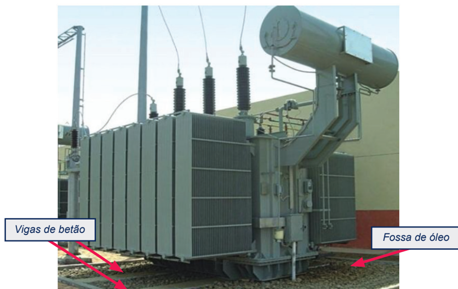
Figura 19.1. – Montagem de um transformador
