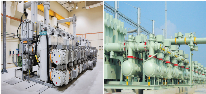
Figura 5.3. – Exemplos de GIS para montagem interior (esquerda) e para montagem exterior (direita)
