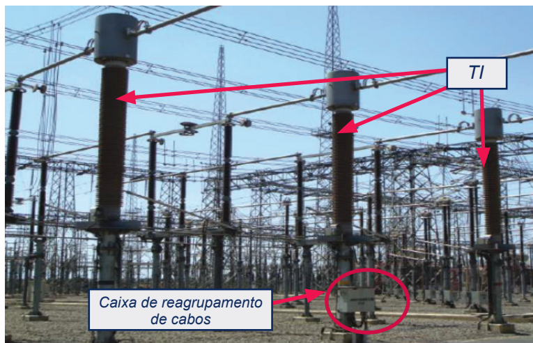
Figura 21.1. – Caixa de reagrupamento de TI
