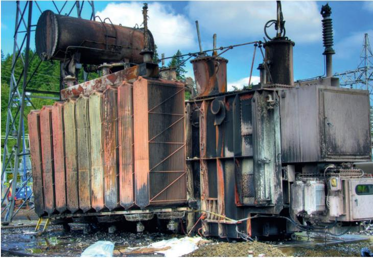
**Figura 58** – Transformador após um incêndio
