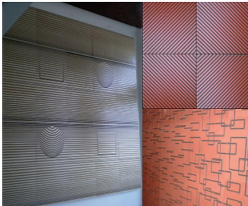
**Figura 6.29:** Painéis com estética inovadora para correção acústica interior
