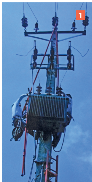
■ (1) Poste com equipamento de corte e transformador aéreo; (2) Transformador aéreo exterior.
