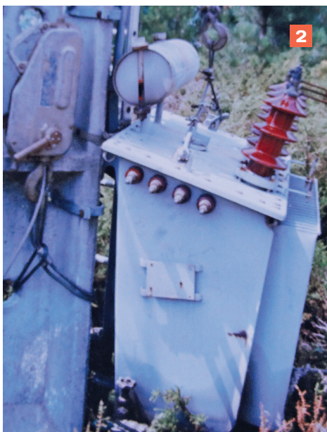
■ (1) Poste com equipamento de corte e transformador aéreo; (2) Transformador aéreo exterior.
