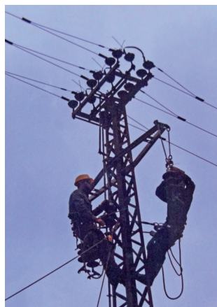
1ª Fase do trabalho, em que é feita a montagem de equipamentos e a análise dos componentes onde se vai intervir
