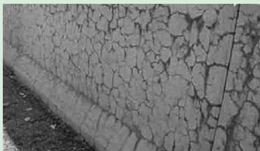
**Figura 40.** Aspeto típico de fendilhação provocada por reação alcali-silica.
