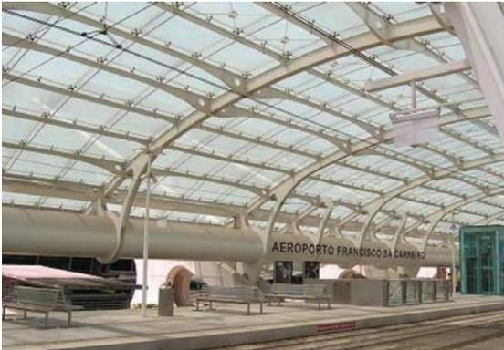
Figura 3 - Estrutura metálica, contendo construção soldada, nas estruturas do Aeroporto Francisco de Sá Carneiro (Porto).
