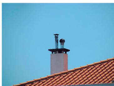
d) Geometria inadequada, não funcional, risco de infiltrações
