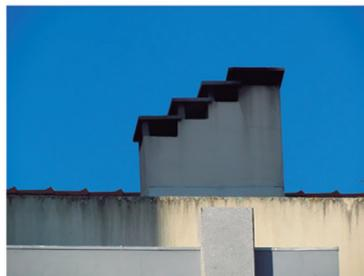
h) Geometria inadequada, não funcional, risco de infiltrações
