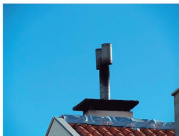
b) Geometria inadequada, não funcional
