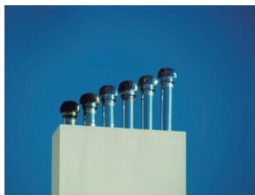
f) Geometria inadequada, risco de infiltrações
